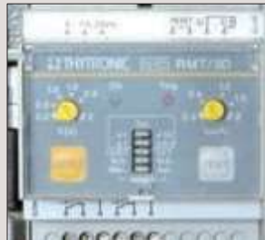
INTERRUTTORE DIFFERENZIALE EARTH FAULT BREAKER
